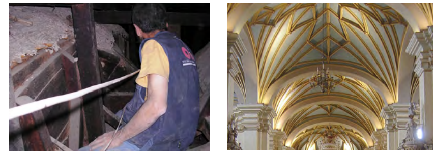
Figura 4: a) Extradós de las bóvedas encamionadas en la Catedral de Lima (foto propia). b) Intradós de las bóvedas encamionadas de la Catedral de Lima (foto propia).
