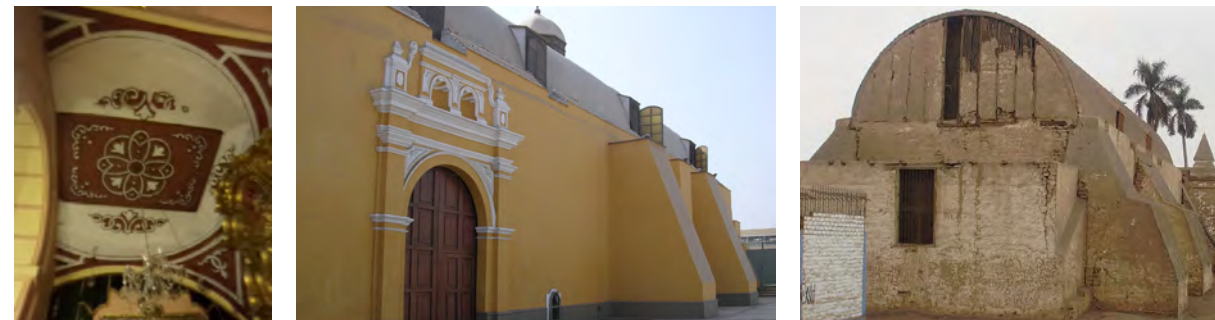
Figura 3: a) Interior de la iglesia La Merced donde el arco y estribo interrumpen el trazo de la cúpula original (foto propia). b) Estribos de la iglesia Santiago Apóstol de Surco (foto propia). c) Estribos de la iglesia San Pedro de Carabaylo (foto propia).
