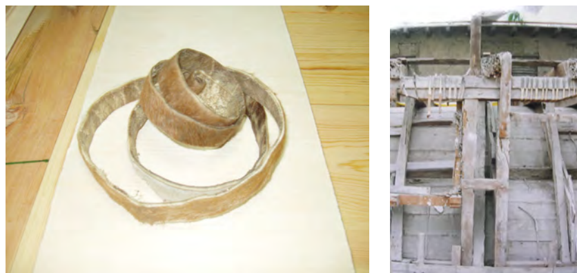
Figura 8: a) Cintas de cuero de ganado vacuno, similar a las que se empleaban en el Virreinato de Perú (foto propia). b) Cintas de cuero que atan las vigas de la capilla de la Virgen de Loreto, Casona de San Marcos (foto propia).
