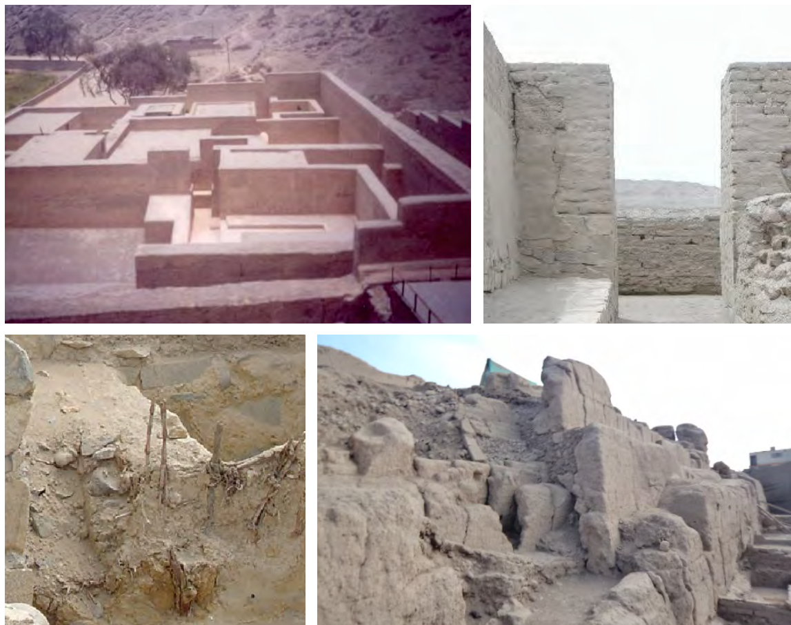
Fig.1: a) Muros ortogonales arriostrados perpendicularmente entre ellos en Puruchuco (foto propia). b) Muros de grandes espesores y poca altura en Pachacamac (foto Fernando Fujita). c) Reconstrucción de contrafuertes en muros de tapia en Mateo Salado (foto propia). d) Fibras vegetales dentro de los muros de Caral (foto propia).
