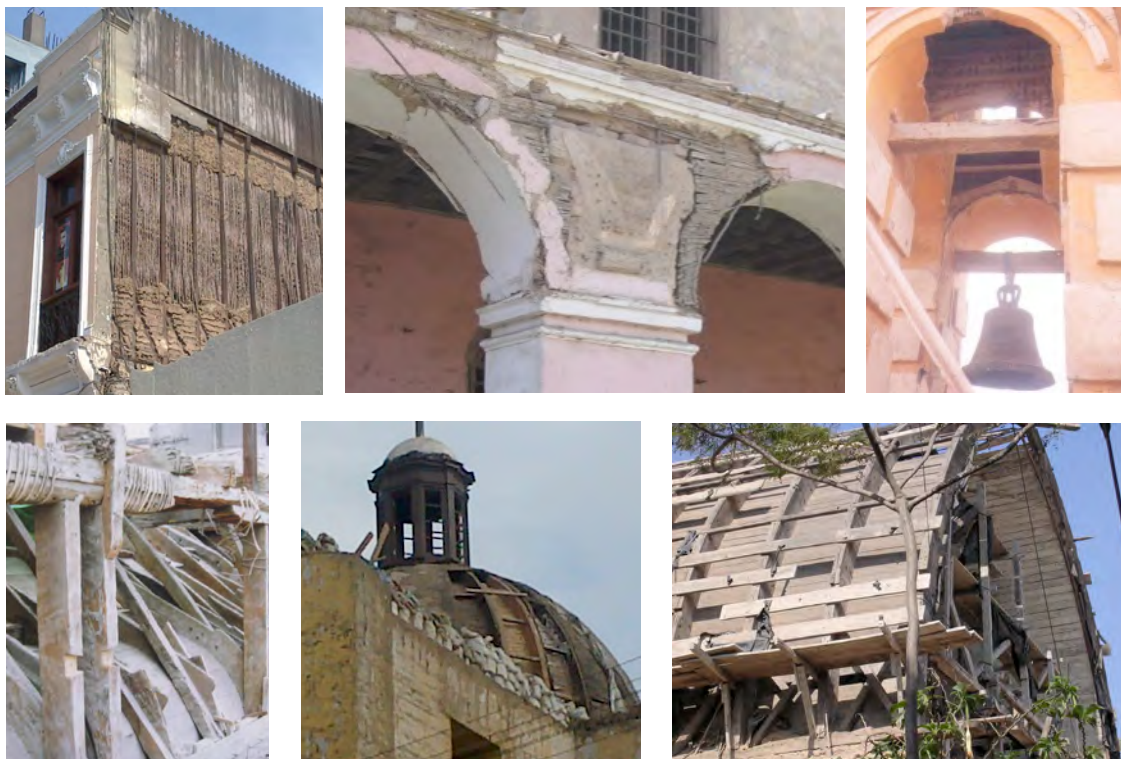
Figura 6: a) Telar de quincha en casa del centro histórico de Lima (foto propia). b) Campanario de entramado en la antigua iglesia La Compañía de Pisco (foto propia). c) Arquería de entramado en la Hacienda San Juan de Surco (foto propia). d) Extradós de las bóvedas encamonadas en la capilla de la Virgen de Loreto en la Casona de la Universidad Nacional Mayor de San Marcos (foto propia). e) Extradós de la bóveda de época Republicana de la iglesia de La Ermita Barranco, que muestra la tipología de bóvedas autoportantes similares a las de época virreinal (foto propia). f) Extradós de la cúpula de la iglesia La Soledad (foto propia).
