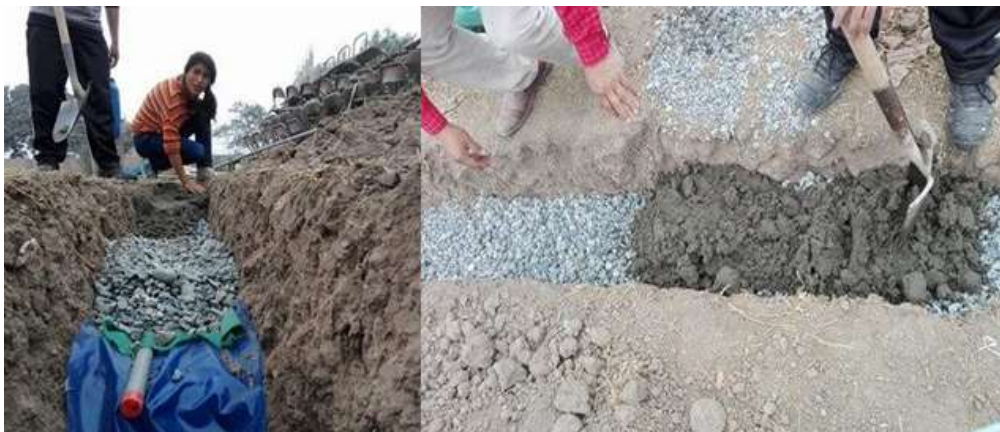
Figura 3. Relleno de la zanja de infiltración tipo Normal, primero grava, seguido de la arena fina.
