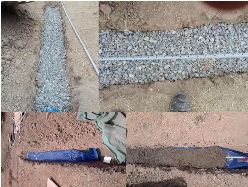
Figura 2. Relleno de la zanja tipo Niimi con arena fija y grava
