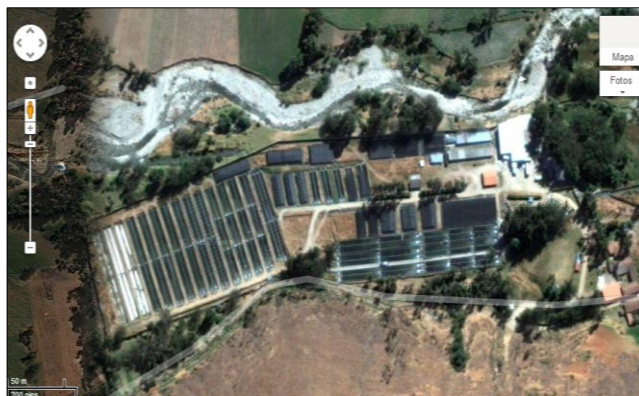
Figura 1. Vista panorámica de las instalaciones del centro de producción de trucha, Junín, Perú
